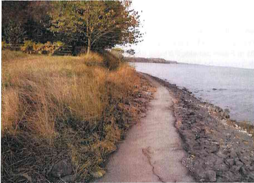
Abbildung 12: Strandabschnitt mit Wasserbausteine und Asphaltbelag
