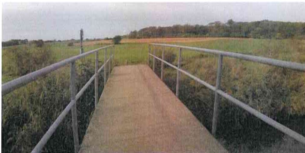
Abbildung 13: Brücke über die Lippingau
