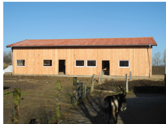
Foto: Ansicht des auszubauenden Seminar- gebäudes
