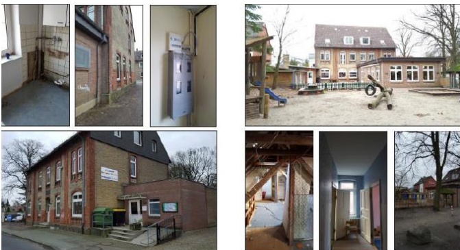
Die Fotos zeigen das stark sanierungsbedürftige Gebäude.
